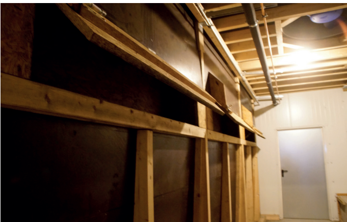
Bedarfsgerechte Umschaltung zwischen Außen- und Maschinenkühlung.
