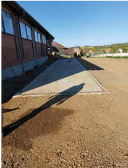
Die Fuhrwerkswaage ist das Herzstück zur Erfassung der Stoffströme bzw. Ernteprodukte und Futtermengen auf dem Betrieb Frese.
