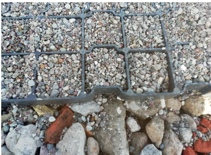
Abbildung 8: Kunststoffelemente zur Bodenbefestigung im Auslauf (© K. Wagner)
