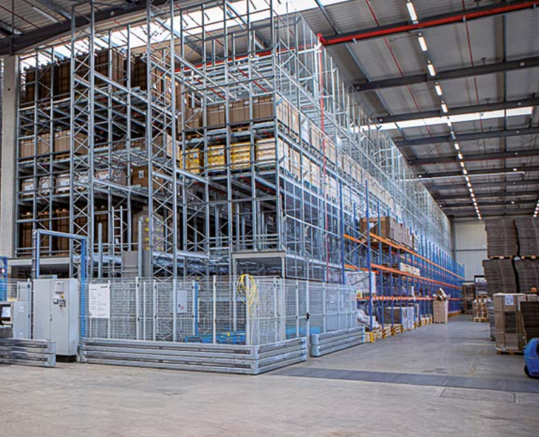
Beide Lagerteile am Standort Alzey bei Dold, das ursprüngliche links, die Erweiterung aus 2022 rechts – sind technologisch jetzt synchron.
