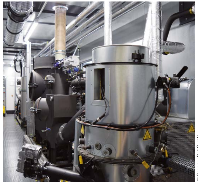
„Re 2 EnergyBlock“ – die vorinstallierte Containerlösung zur dezentralen Energieerzeugung aus Reststoffen
