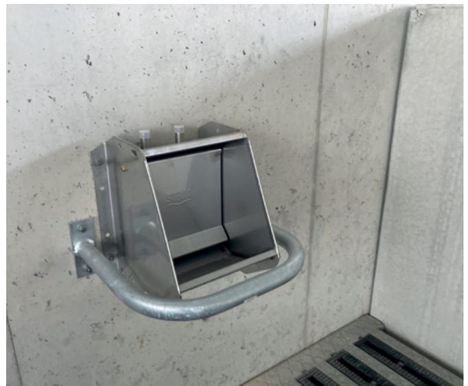
Abbildung 7: Abweiser sollen verhindern, dass in die Tränke gekotet wird
