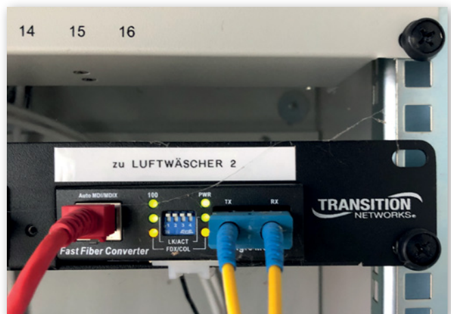
Abbildungen 2 und 3: LWL-Kupplung, links mit Bajonettverschluss, rechts 2x am Medienkonverter (Quelle: Feldmann)
