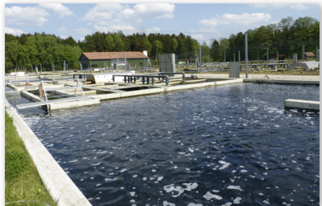
Abbildung 4: Rinnenanlage mit Kreislaufführung und Wasseraufbereitung
